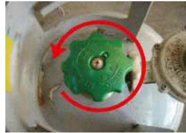
3 点火つまみが『閉』の位置になっている事を確認して、プロパンガスの元栓を**全開**にします。
