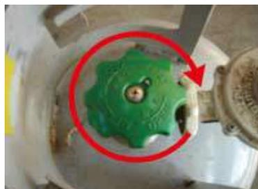
11 消火したことを確認して、プロパンガスの元栓を完全に閉めます。
